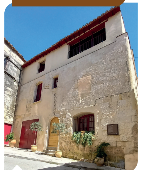
Exemple de travaux réalisés au 2 rue Baudin, avec la Fondation du patrimoine dont le logo est posé sur l'encadrement de la porte d'entrée.
