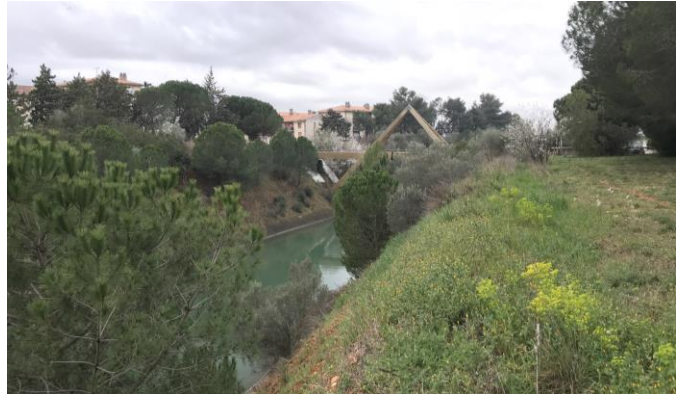
Canal d'irrigation du Bas Rhône Languedoc et ses espaces végétalisés. Source : Verdi
