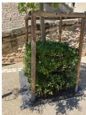
Figure 14 : exemple de délimitation des espaces plantés, limitant le tassement au sol et favorisant l'infiltration en eau
