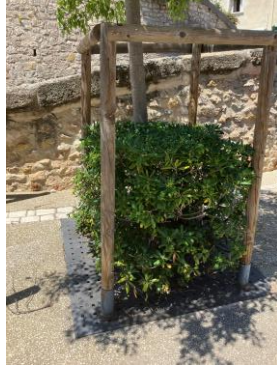
Figure 9 : Exemple de plantation avec la strate arborée et arbustive, avec limitation du tassement des racines et infiltration des eaux pluviales avec grille de pied d'arbres
