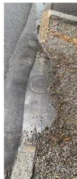
> Eau de ruissellement s'infiltrant dans la tranchée d'un arbre de pluie
