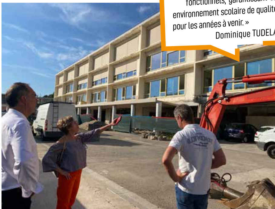
Une visite guidée du chantier pour envisager sereinement la rentrée scolaire avec Dominique TUDELA, 1 ère adjointe au maire, Eddy VALADIER, maire de Saint-Gilles et le responsable des bâtiments de la ville.
